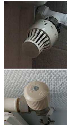
Exemple de robinet à tête thermostatique
