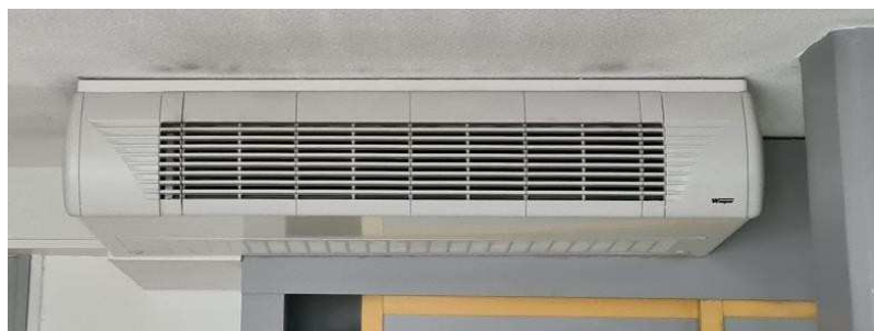
Ventilo convecteur type deux tubes / plafonnier horizontal « Aqu@Fan » - WESPER
